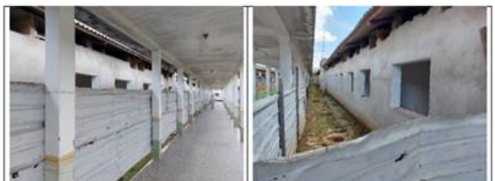
Foto 5 – Detalhe do tapume do canteiro da obra isolando a circulação da parte do hospital que está funcionando.
