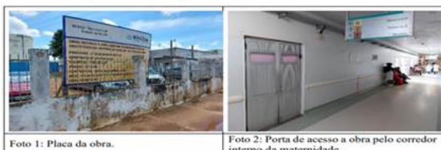
Foto 1: Placa da obra.
