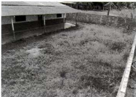
FOTO 10 – MURO DE PROTEÇÃO
