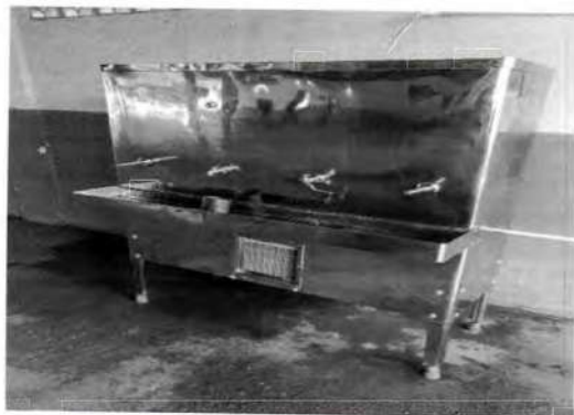
FOTO 12 BEBEDOURO INSTALADO NA ESCOLA
