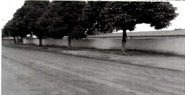
FOTO 01 – MURO DE PROTEÇÃO ESCOLA SOSSEGO DA MAMÃE
