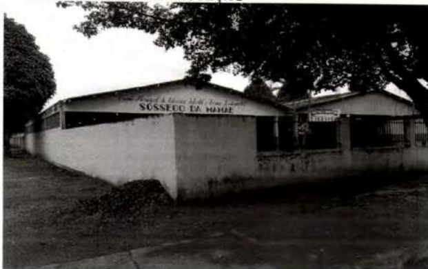
FOTO 02 – MURO DE PROTEÇÃO
