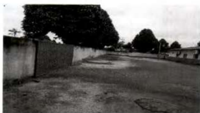
FOTO 03 MURO DE PROTEÇÃO
