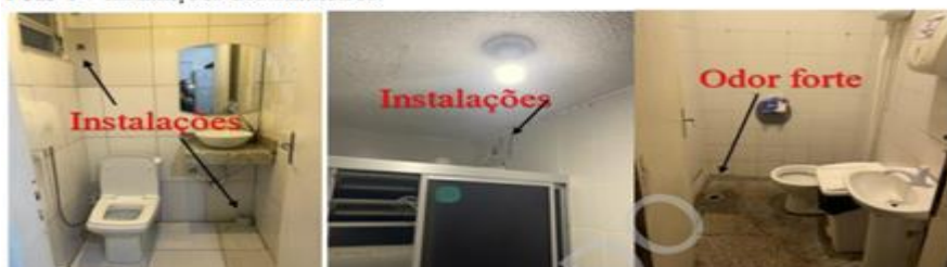
Foto 4 – Instalações dos banheiros
