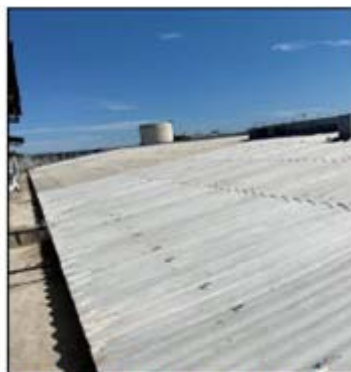
Figura 28 – Parte do telhado substituído
