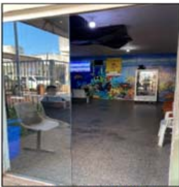
Figura 53 – Porta de entrada do HICD com somente 1 parte com vidro.
