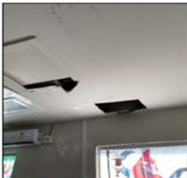
Figura 15 – Forro da enfermaria D
