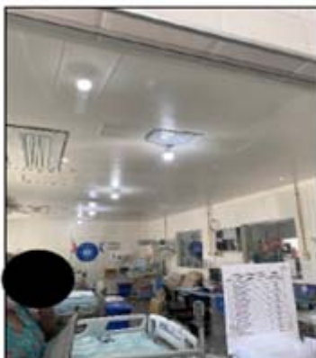
Figura 17 – Forro de gesso os leitos de UTI
