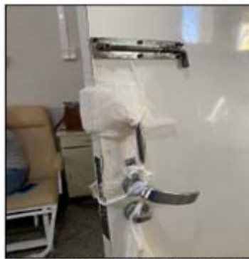
Figura 54 – Porta do banheiro da enfermaria B
