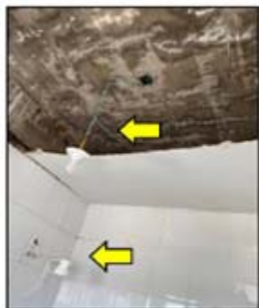
Figura 43 – Banheiro da enfermaria K
