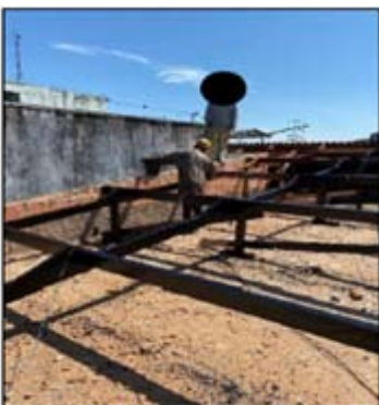
Figura 27 – Aplicação de impermeabilizante para madeira
