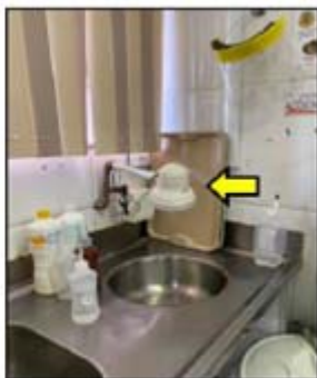
Figura 45 – Instalação de chuveiro na pia.
