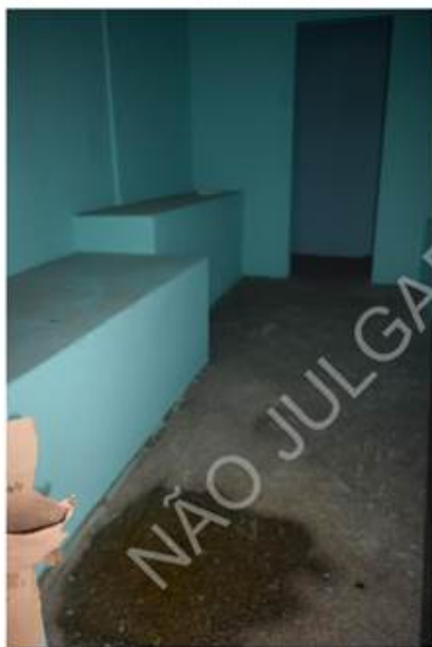
Figura 7 - Alojamento D4 APÓS a reforma apresenta água no piso em tese advinda do teto - Foto produzida pelo MEPCT/RO.
