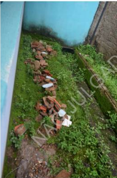
Figura 31 - presença de mofo e entulho em diversos pontos da unidade, necessitando de limpeza e manutenção - Foto produzida pelo MEPCT/RO
