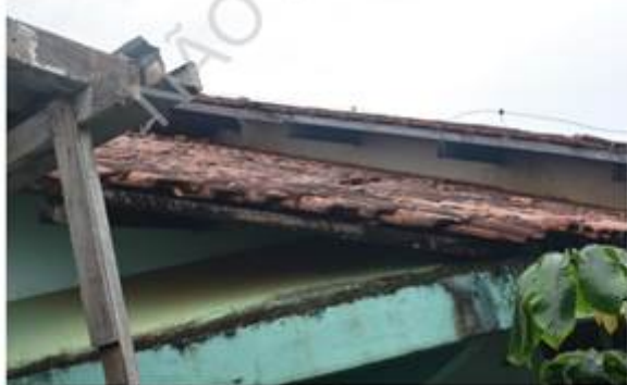
Figura 5 - Foto ATUAL das condições GERAIS do telhado do alojamento. Material produzido pelo MEPCT/RO.
