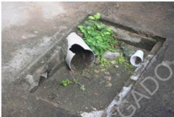
Figura 17 - Cano de esgoto que em tese os dejetos que saem dos alojamentos correm sem nenhuma higiene, necessitam de manutenção - Foto produzida pelo MEPC/RO
