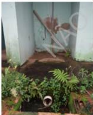
Figura 17 - Cano de esgoto que em tese os dejetos que saem dos alojamentos correm sem nenhuma higiene, necessitam de manutenção - Foto produzida pelo MEPC/RO
