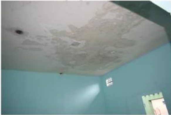
Figura 9 - Condições do teto e luminárias instaladas nos tetos de alguns Alojamentos APÓS a reforma. Demonstrando que a umidade / infiltrações persistem, inclusive comprometendo as luminárias instaladas - Foto produzida pelo MEPC/RO
