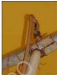
Figura 121 – improviso para retirada de ar da tubulação de recalque
