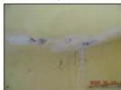
Figura 125 – possível patologia de impermeabilização da laje inferior do reservatório elevado com oxidação das armaduras afetadas
