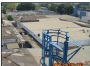
Figura 146 - ausência de SPDA. Cobertura vista à nordeste a partir da torre de água
