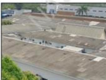
Figura 144 - ausência de SPDA. Cobertura vista à noroeste a partir da torre de água
