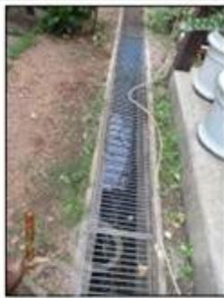
Figura 65 - Central-dialise (esgoto na caixa de drenagem pluvial)
