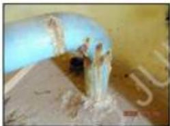
Figura 122 – tubulação de recalque necessitando reparos
