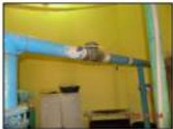
Figura 120 – improviso para retirada de ar da tubulação de recalque
