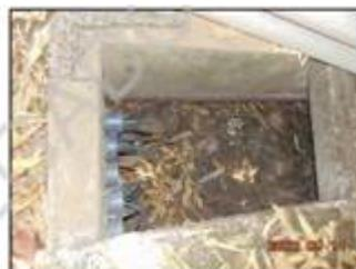
Figura 79 – Caixa de passagem de fios da Subestação, com entrada de água da chuva. Também afetada por raízes de árvore no entorno
