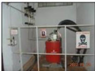
Figura 126 - transformador existente de 1000 kva
