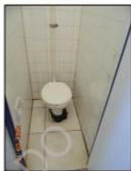
Figura 157 – Centro Obstétrico. Banheiro sem dispositivos de acessibilidade
