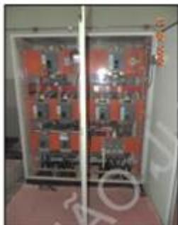
Figura 128 - painel de distribuição e circuitos com peças obsoletas para a atual demanda de consumo de energia
