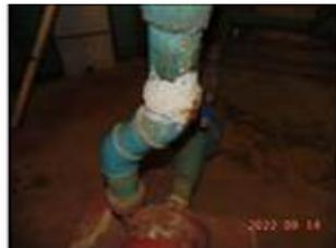
Figura 119 – improviso para estanqueidade da tubulação de recalque
