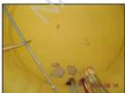
Figura 124 – desagregação do concreto e oxidação de armaduras na laje do primeiro pavimento do reservatório elevado
