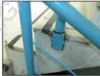
Figura 153 – escada rompida em mais de um ponto, no pavimento da direção
