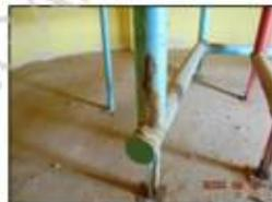
Figura 123 – tubulação de recalque necessitando reparos
