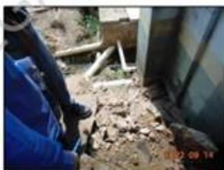
Figura 67 – Adaptação da rede hidrossanitária pela incompatibilidade da ampliação com o sistema anterior
