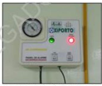
Figura 117 - UTI Bloco O. Disparado o alarme e apresentando baixa pressão
