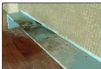
Figura 90 - Lateral de edificação próximo a radiologia. Banco afetado por drenagem de ar condicionado
